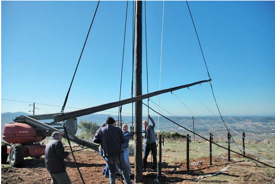
Fig. 50 – Primeira montagem do telégrafo e elementos das equipas.
